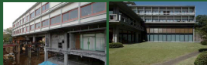
国際文化会館 1955年の松山謙吾の共同設計。2006年、地下に増築し再生。土が工事中、露出した地盤有形文化財。
