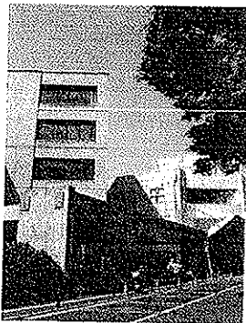
7 第二庁舎（玄関庇）
