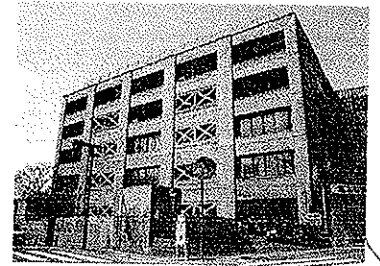
6 第二庁舎（南東側）
